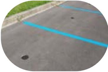
Le capteur de stationnement IoT est un dispositif idéal pour une stratégie à court terme comme à long terme. Simple d'installation, il s'intègre **par carottage directement dans le revêtement de sol**. Il peut être installé sur les places de stationnement extérieur ou dans les parkings couverts.
